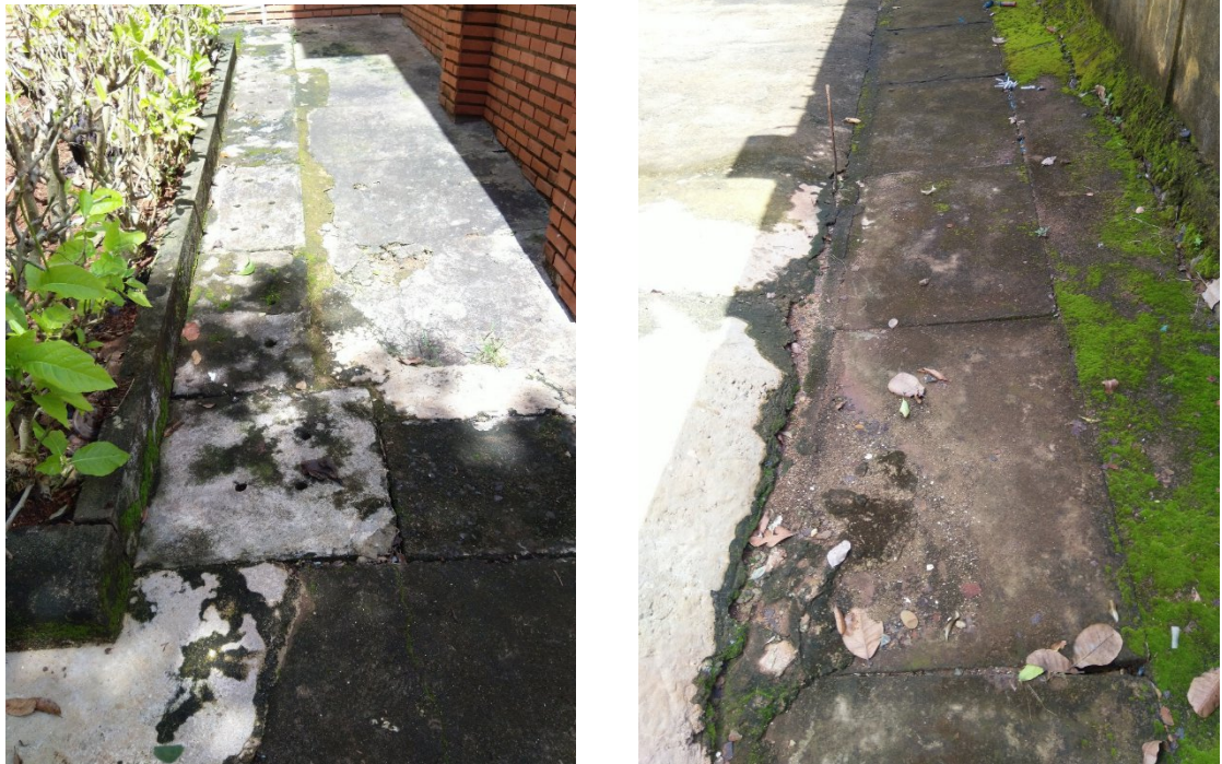
Hình 3. 1: Một số hình ảnh hệ thống thu gom, thoát nước mưa hiện hữu
